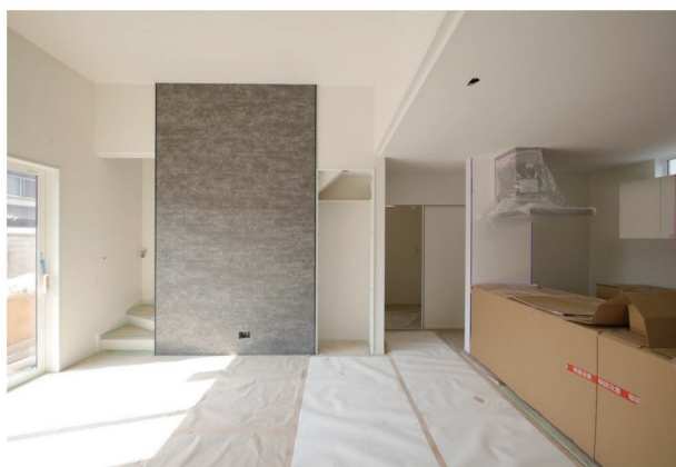
工事中の写真です
